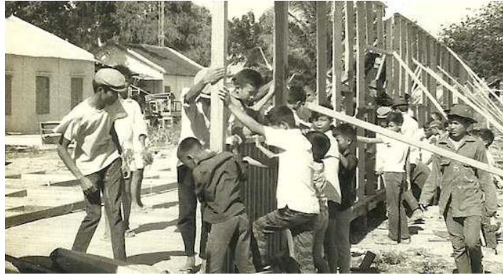
Đoàn thiện chí xây dựng ký túc xá An Phước
