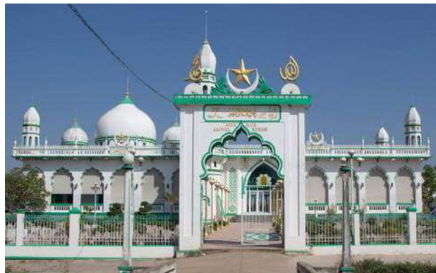
Hình 54. Thánh đường Masjid Jamiul Azhar thuộc Châu Phong, Tân Châu, An Giang, được xây dựng từ năm 1959. Ảnh: Internet.
