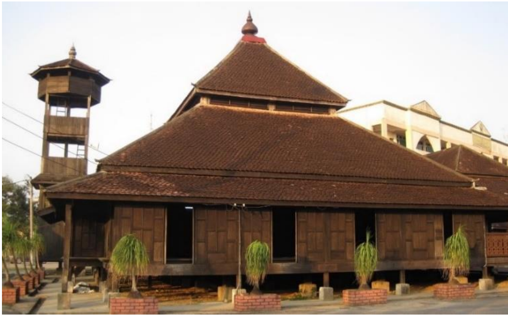
Hình 5. Thánh đường cổ Kampung Laut, do người Champa xây trong khuôn viên Penkalang Chepa vào thế kỷ 17 thuộc tiểu bang Kelantan, Malaysia. [Serambi Makah].
